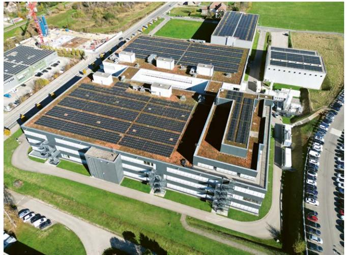
Au printemps 2024, l'entreprise a terminé l'installation de près de 6400 m<sup>2</sup> de panneaux photovoltaïques qui assurent désormais une autoproduction d'énergie durable et exempte d'émissions, couvrant ainsi près de 10% des besoins de l'ensemble du site.
